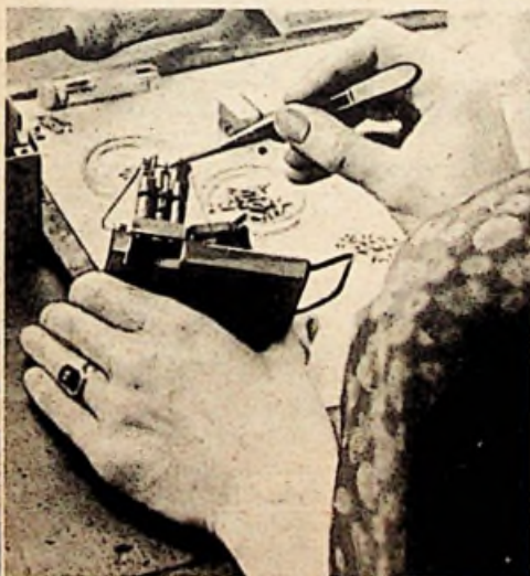
Der Rahmen wird an der Halterung befestigt
